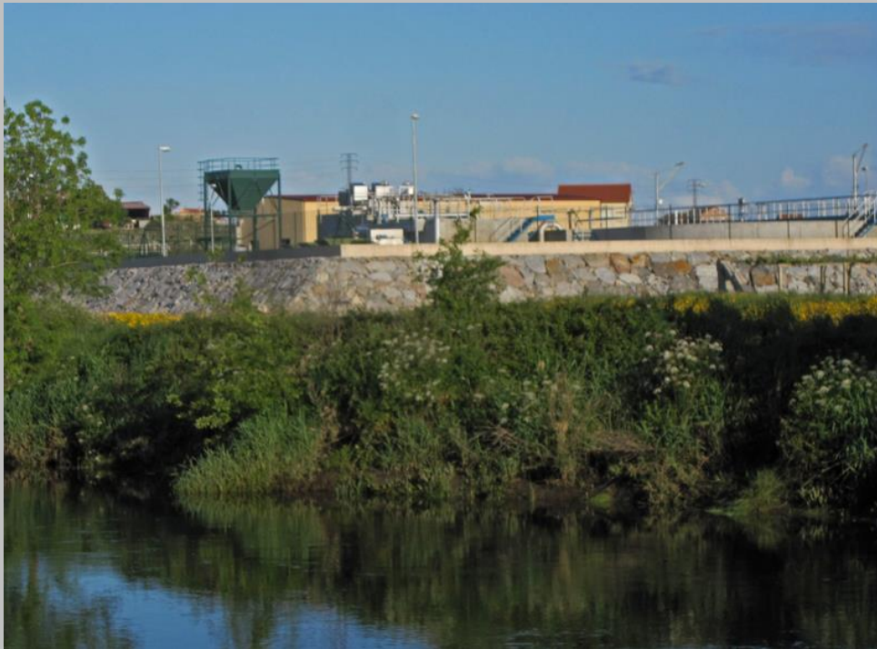
Depuradora de augas residuais
